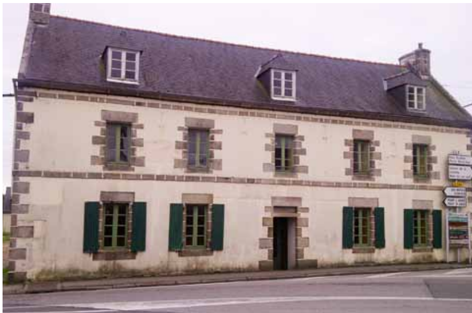
Ci-dessus : le futur bâtiment de l'Office de Tourisme
